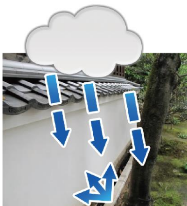
瓦に煤煙、黄砂、苔等が雨によって 落下し壁等に付着。
